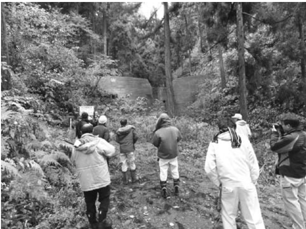
治山ダムの木製残存型枠
