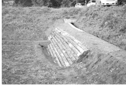
法留工現場①
