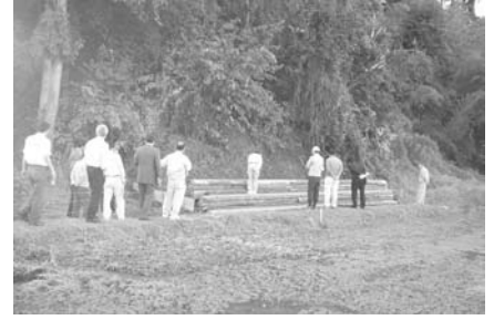
法留工現場②
