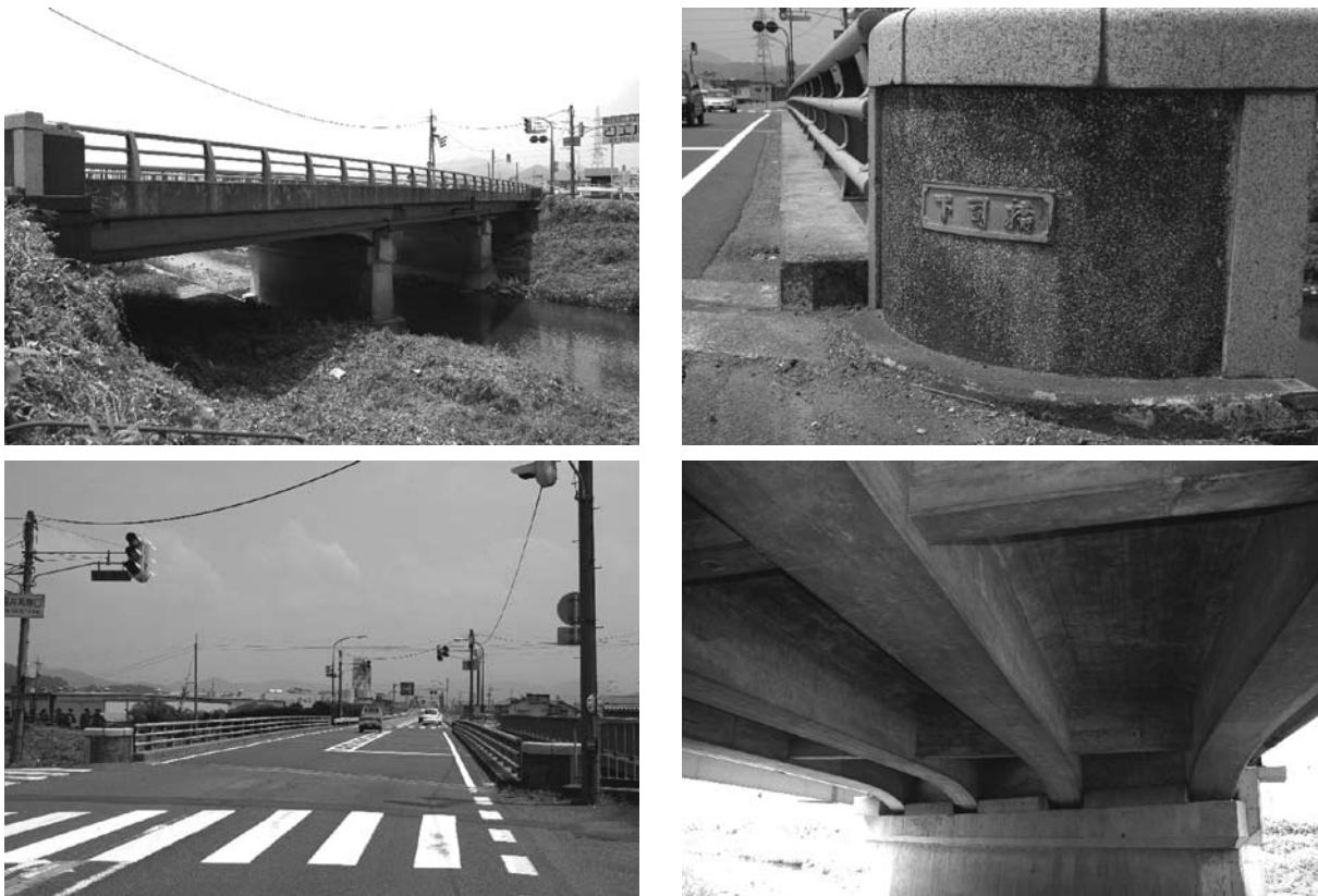
写真-10.4.1 下司橋の現況写真
