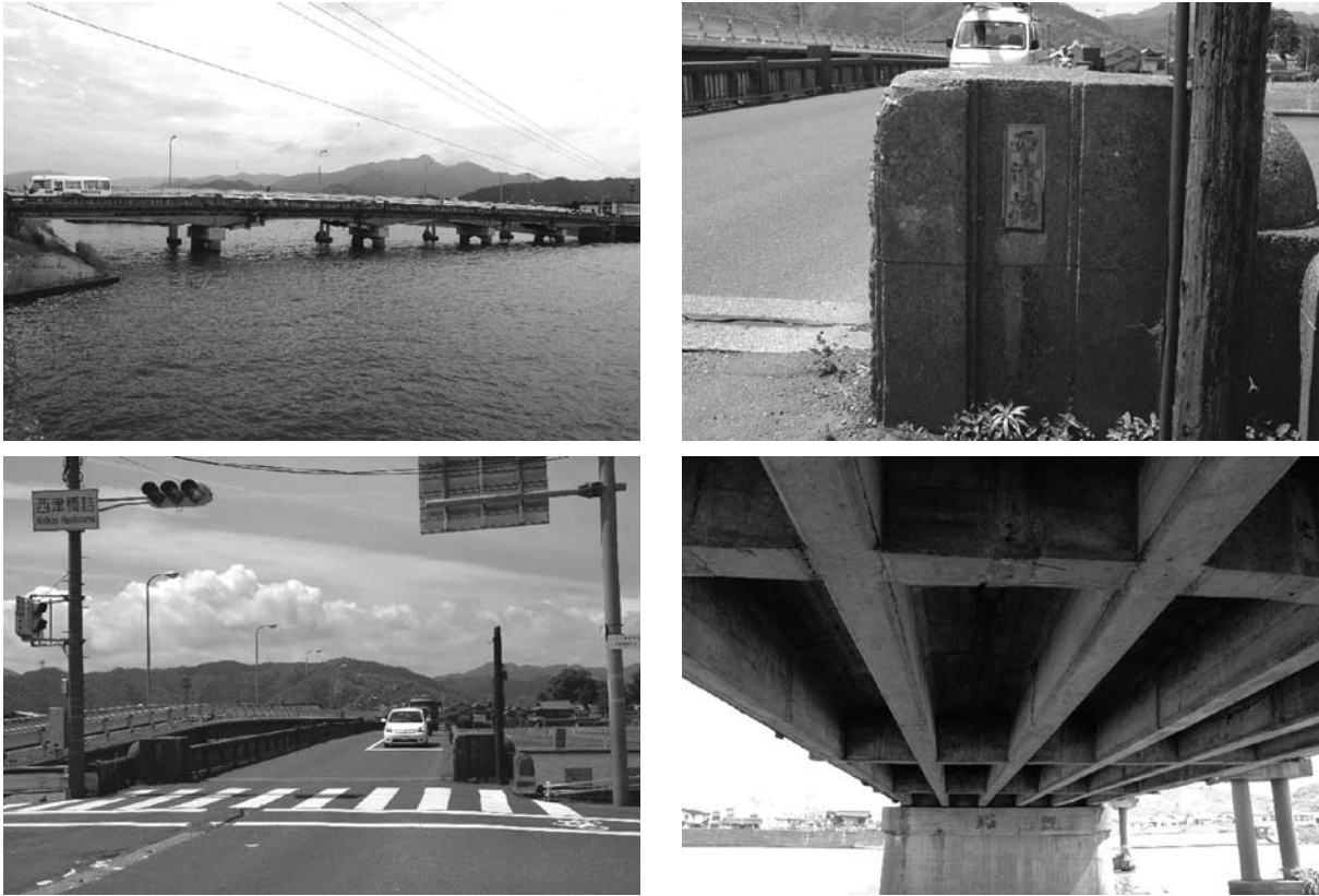
写真-10.4.3 西津橋の現況写真
