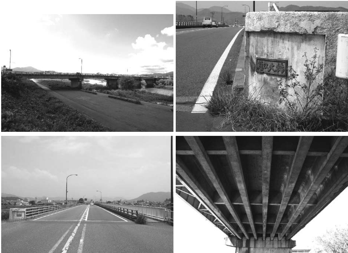
写真-10.4.2 鯖江大橋の現況写真
