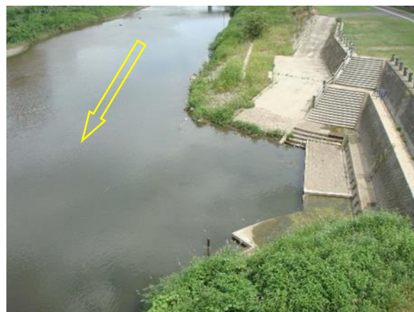
写真-4 舟着用デッキ整備後の状況 (平成26年7月1日)
