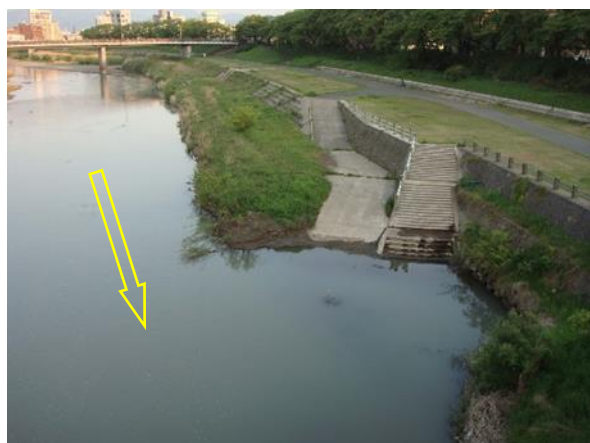
写真-3 舟着用デッキ整備前の状況 (平成25年5月5日)
