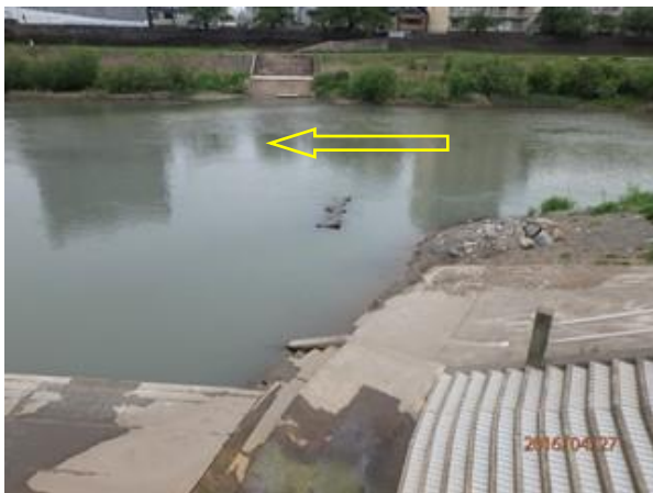
写真-7 設置後の水制工 (平成 28 年 4 月 27 日)
