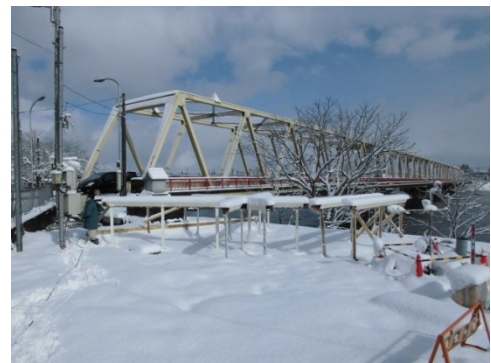
写真-6 屋外実験箇所の状況 2016/3/1 撮影
