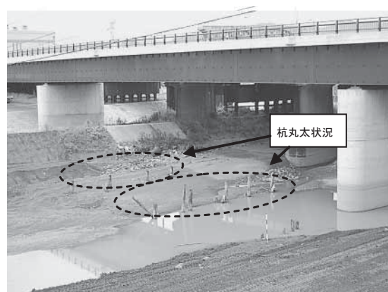
写真-1 掘り出し前の杭丸太状況
