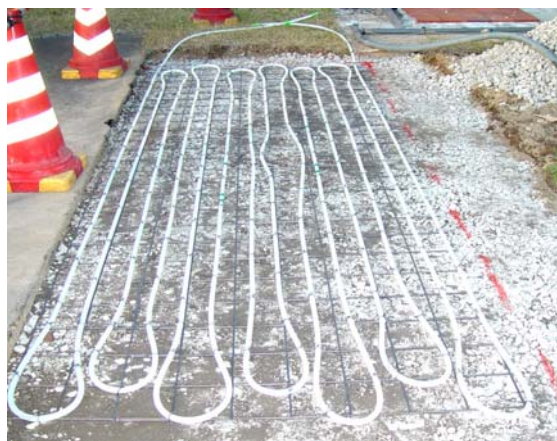
写真-1 ポリエチレン管敷設状況
