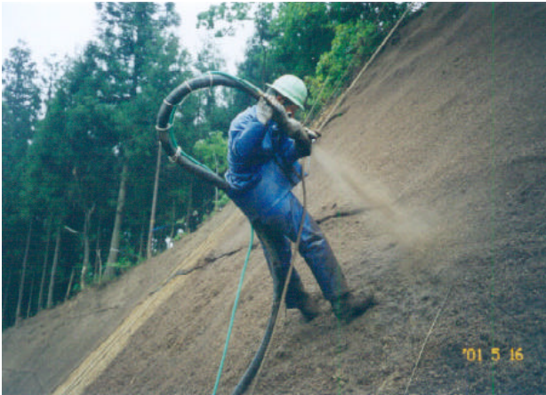
図 6 吹付緑化施工（D 区）
