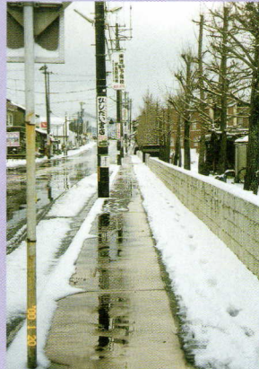
歩道融雪装置あり
