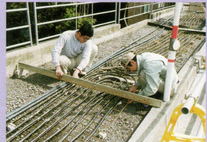
歩道放熱部を現場施工
