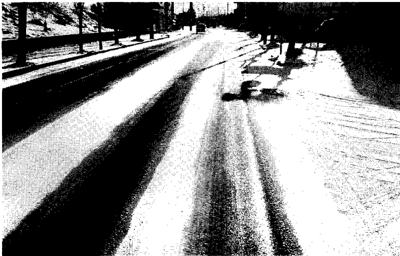
8 : 10 (16分経過) 60m地点まではわだち部の路面が完全に露出。
