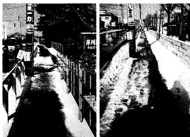
写真-6 放熱管ユニット単位での融け残り
