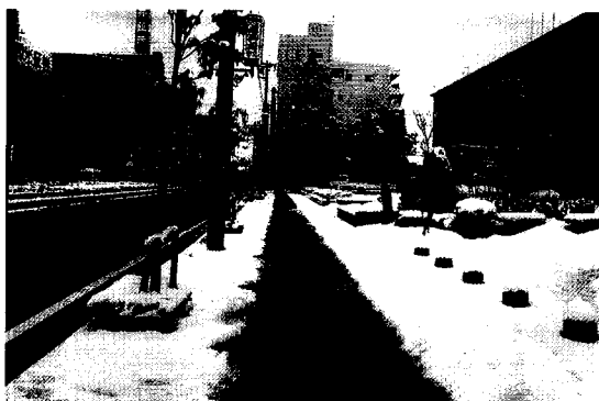
◀セット融雪施工例(福井県武生市役所前)
