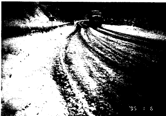
写真 凍結抑制舗装 (ノンフリーズ骨材)
