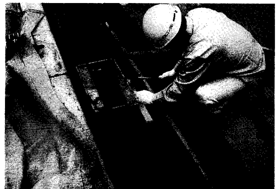
写真-10 狭小部締め固め
