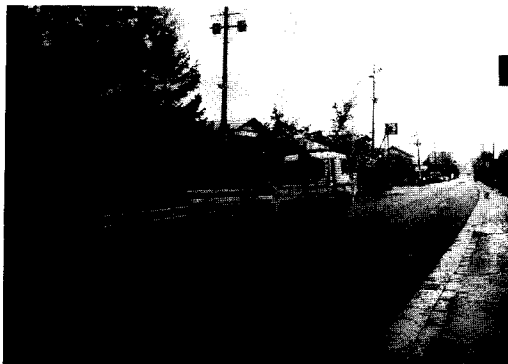
写真-4 排水性舗装施工後
