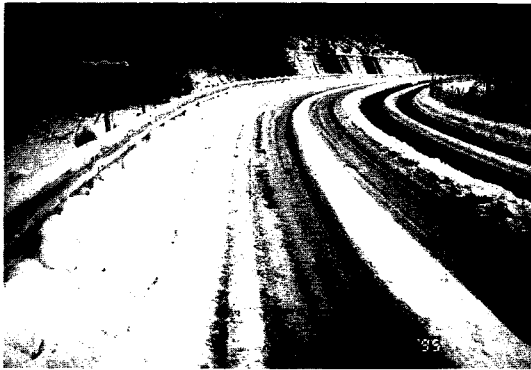
写真 凍結抑制舗装 (マフィロン)
