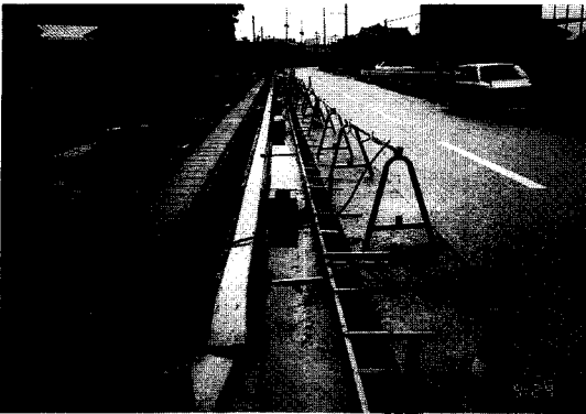
写真-4 施工前 タンパーを使用するため型枠の補強を図る
