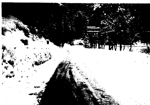
写真 凍結抑制舗装 (ノンフリーズ骨材)
