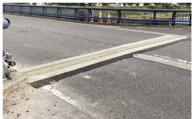
施工試験で設置した試作品 (福井市内)
