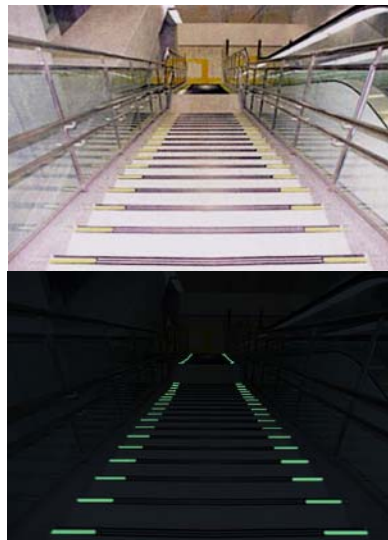
セラチックウタイル施工例 (横浜市営地下鉄駅構内)
