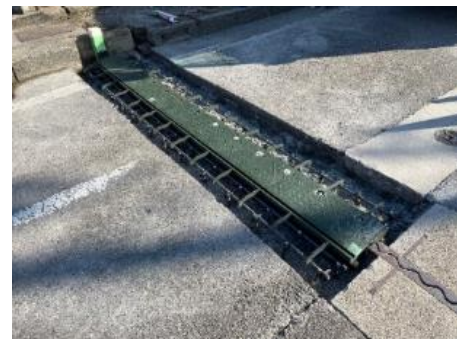
図2 実橋での施工 (保護コンクリート打設前)
