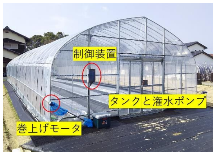
ハウス内外における IoT 環境制御システム
